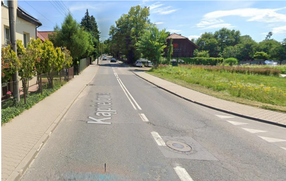
Fot. 1 Istniejące zagospodarowanie terenu. Widok na lokalizację planowanego przejścia dla pieszych
