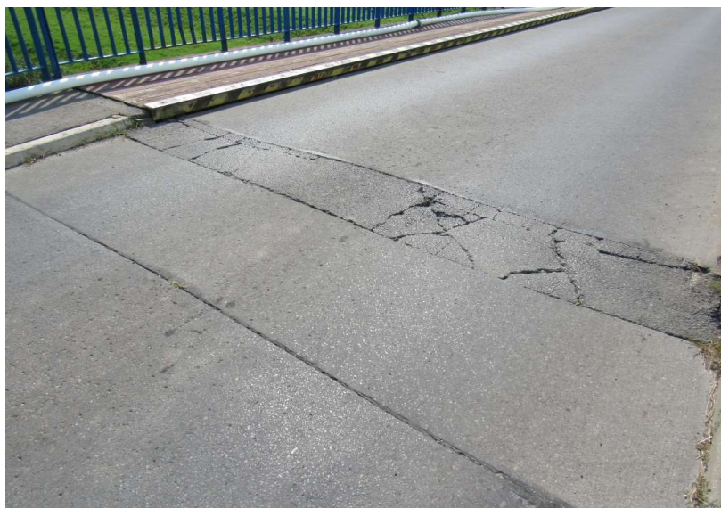
FOT. 2.2. WIDOK PRZESŁA I PRZYCZÓŁKA - od dołu
