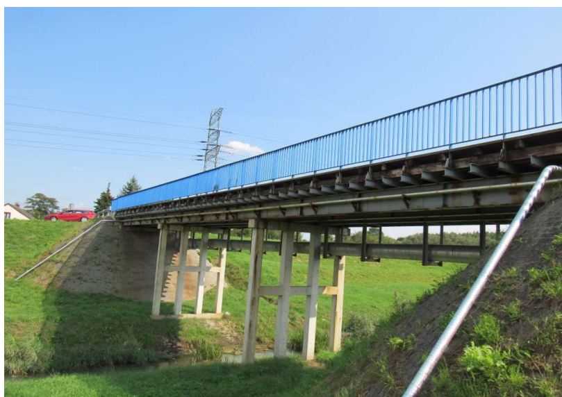
FOT. 1.2. WIDOK OBIEKTU Z GÓRY na jezdnię
