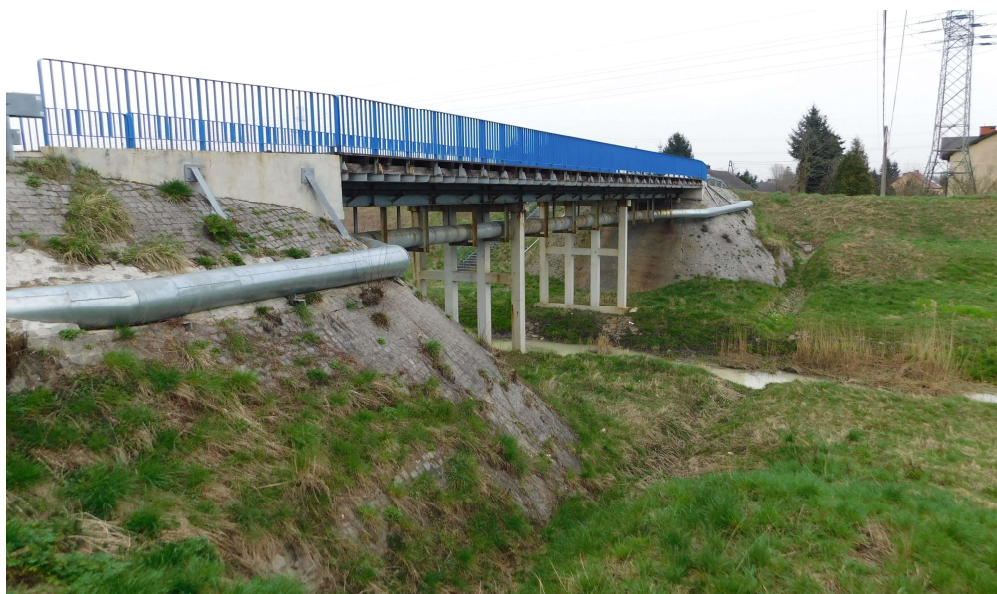
FOT. 3.2. WIDOK PODPORY NR 1 - PRZYCZÓŁKA OD STRONY ZACHODNIEJ
