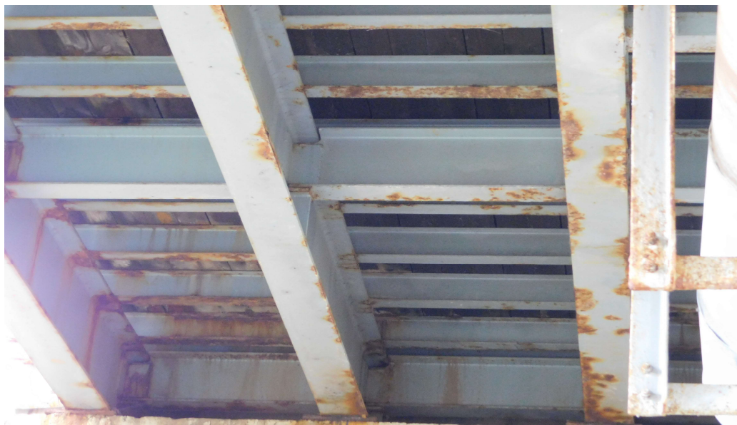
FOT. 4.3. WIDOK PODPORY NR 2 - FILARA OD STRONY ZACHODNIEJ
