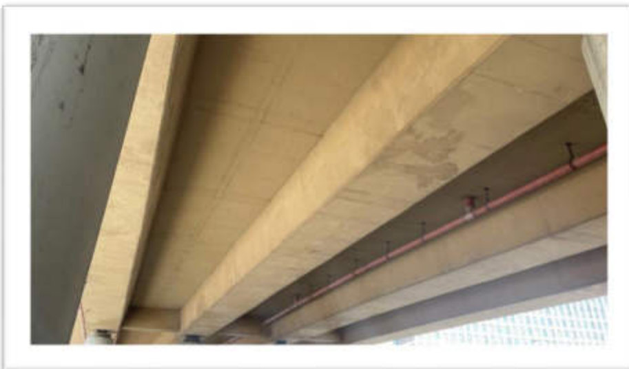
Fot 7. Estakada – spód konstrukcji
