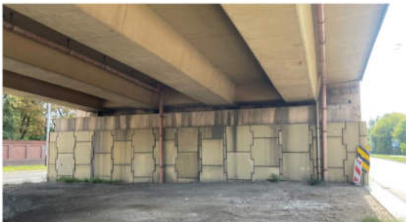
Fot. 9. Podpora nr 8 - widok ogólny
