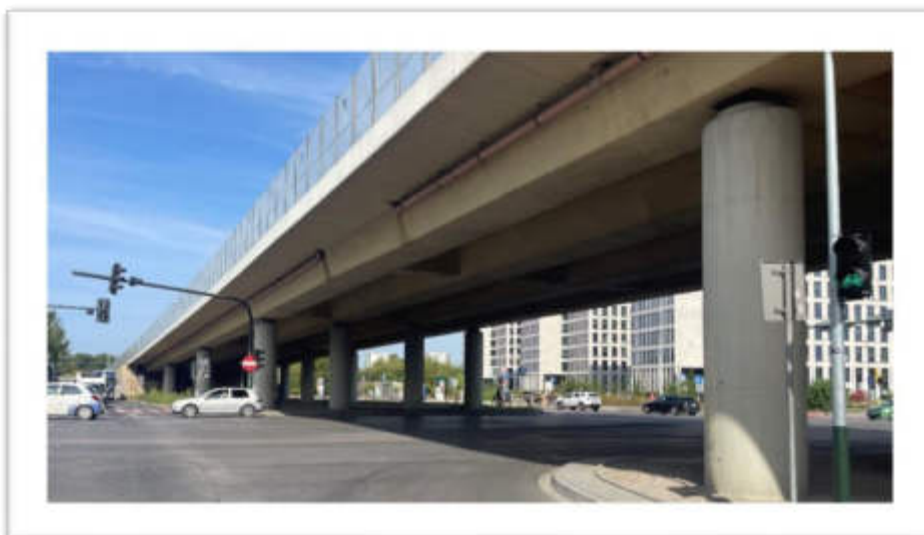
Fot. 1 Estakada - widok z boku od strony południowej
