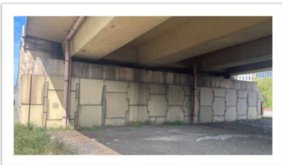
Fot. 8. Podpora nr 1 - widok ogólny
