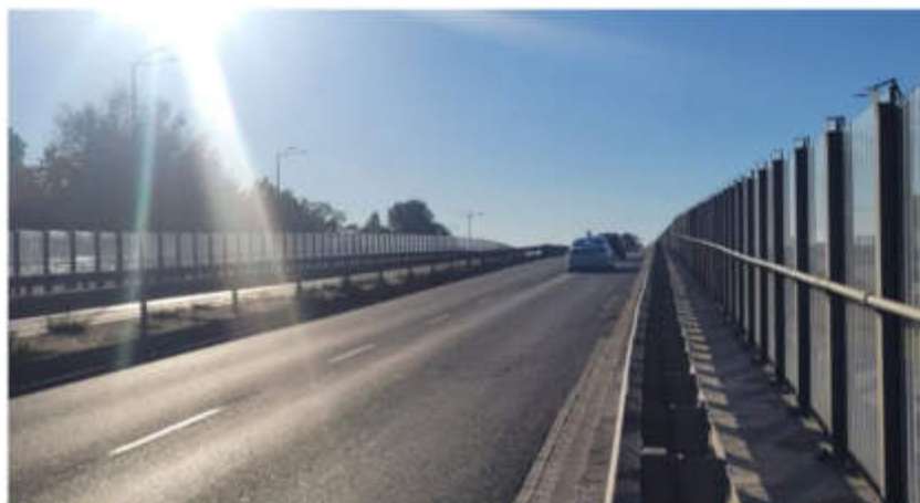
Fot 10. Najazd wschodni – część przejazdowa
