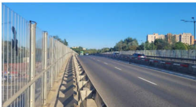
Fot 11. Estakada – część przejazdowa
