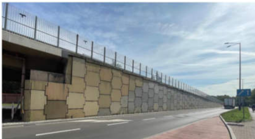
Fot. 3 – Mur oporowy południowo-wschodni
