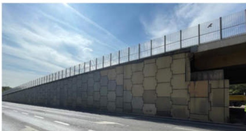
Fot. 5 – Mur oporowy północno-wschodni
