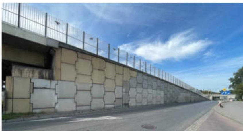
Fot. 4 – Mur oporowy północno-zachodni
