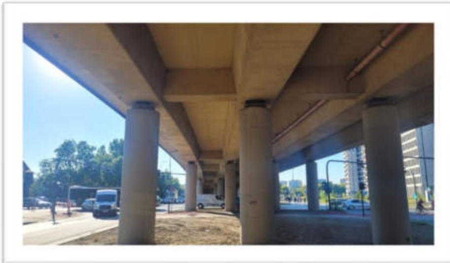
Fot 6. Estakada – przestrzeń pod obiektem
