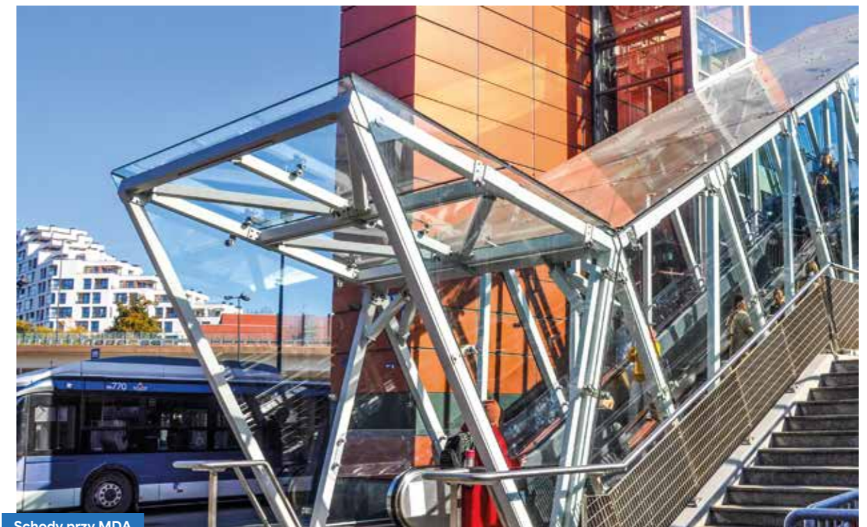
Schody przy MDA
