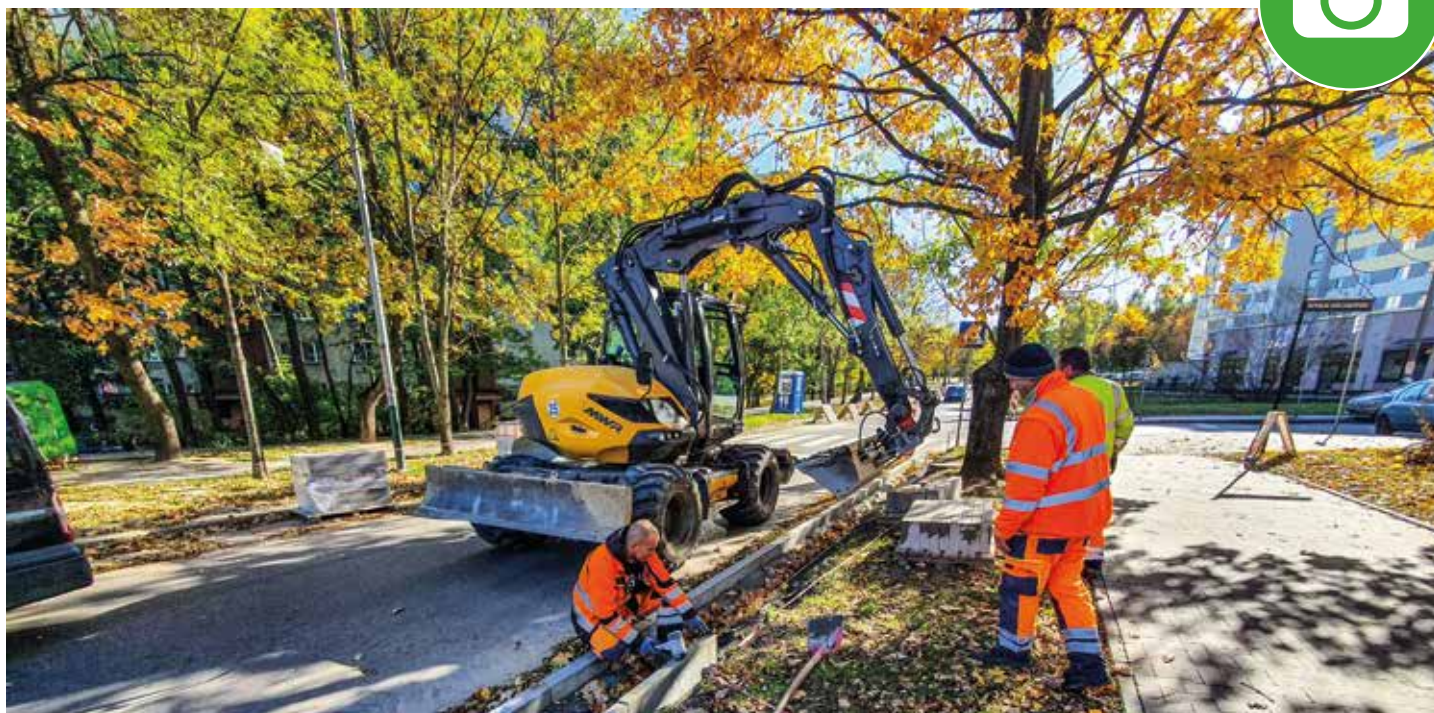
Remont jezdni i chodnika na ulicy Konrada Wallenroda na odcinku od Teligi do Ściegiennego
