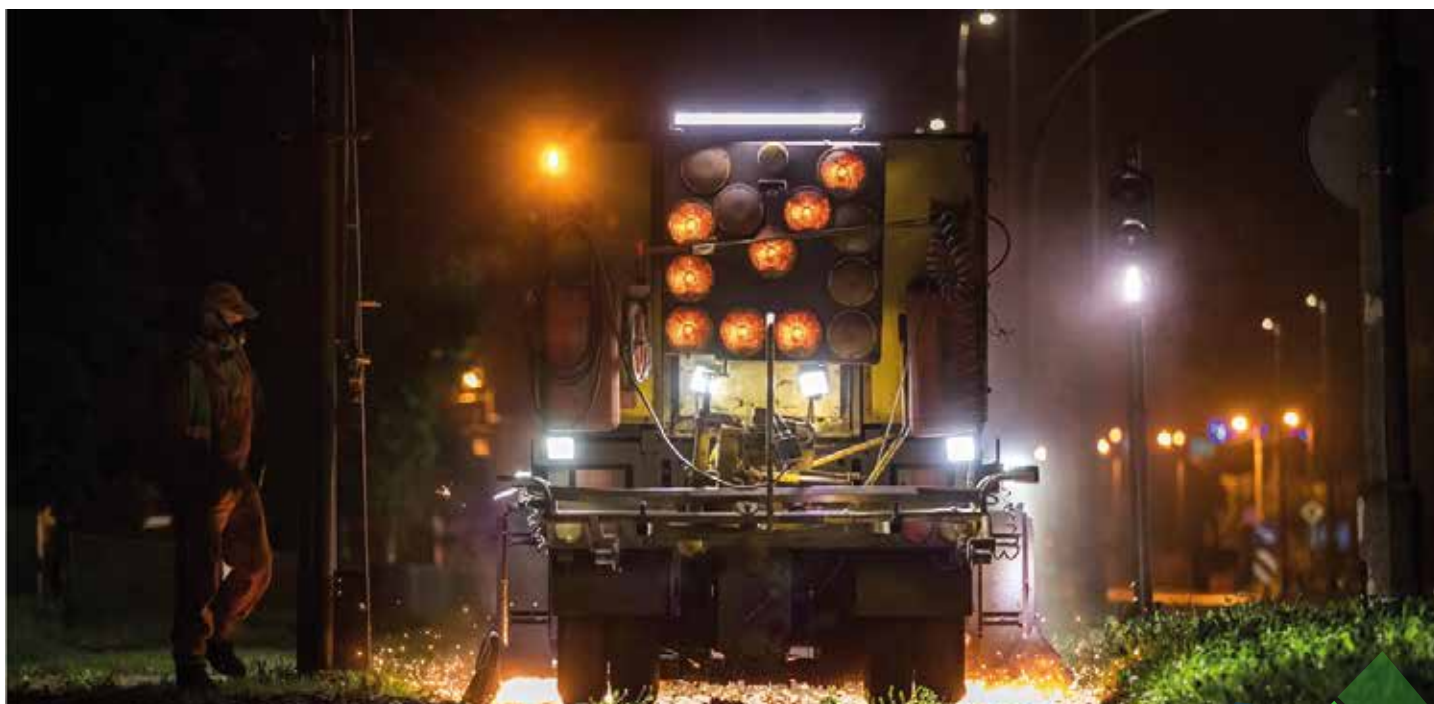
Nocne szlifowanie torowiska tramwajowego - ulica Bronowicka
