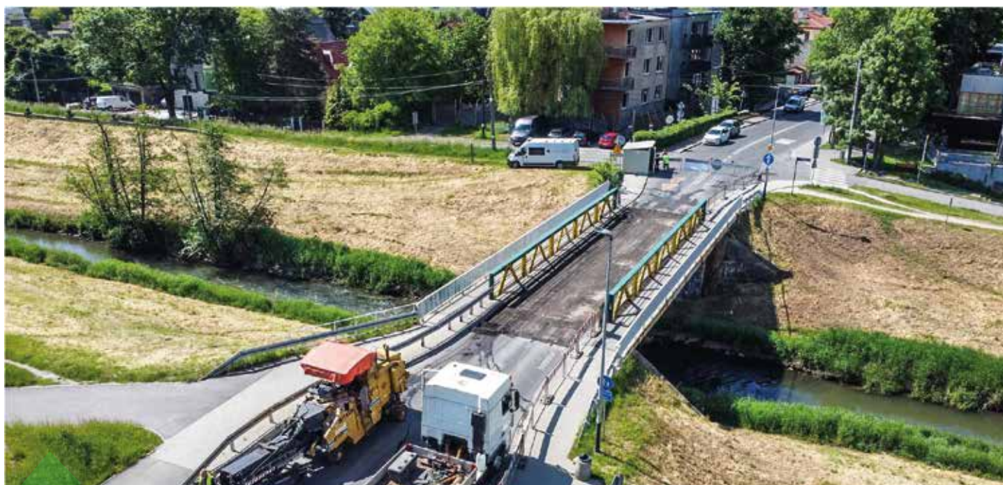
Remont mostu nad rzeką Rudawą w ciągu ulicy Piastowskiej
