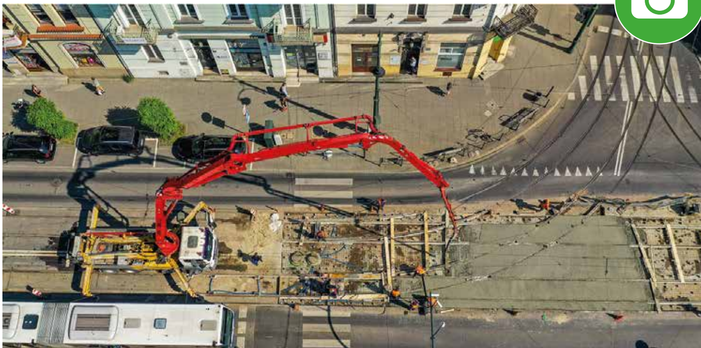
Naprawa torowiska tramwajowego na węźle Lubicz-Rakowicka
