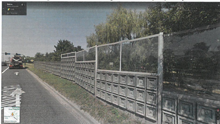
Fotografia 2.2 Fragment ekranu betonowego ze szkłem akrylowym. Część B. Ulica Wielicka.
