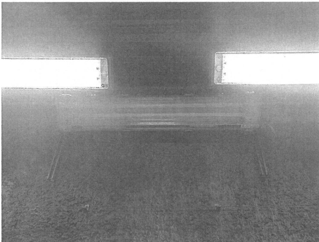
Zdjęcie 7. Oprawa typu EM - ESPERIA INOX ETRC 236 IP65 prod. RIDI (środkowa)
