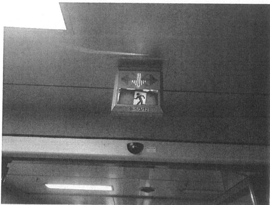
Zdjęcie 1. Oprawa typu DER - oprawa dynamicznego oświetlenia ewakuacyjnego FL6000
