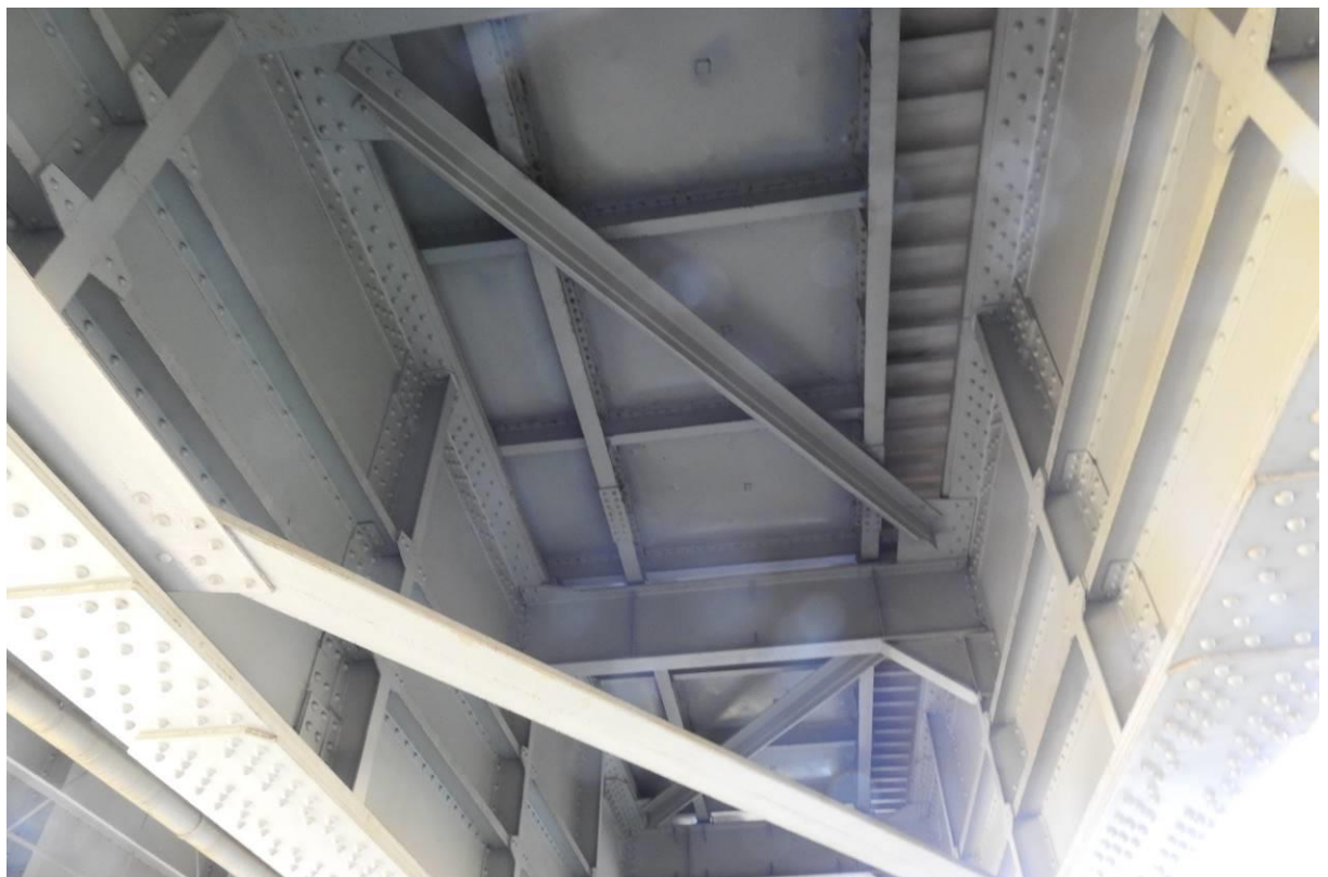
Fot. 1.5. Widok ogólny od spodu na ruszt przęsła.
