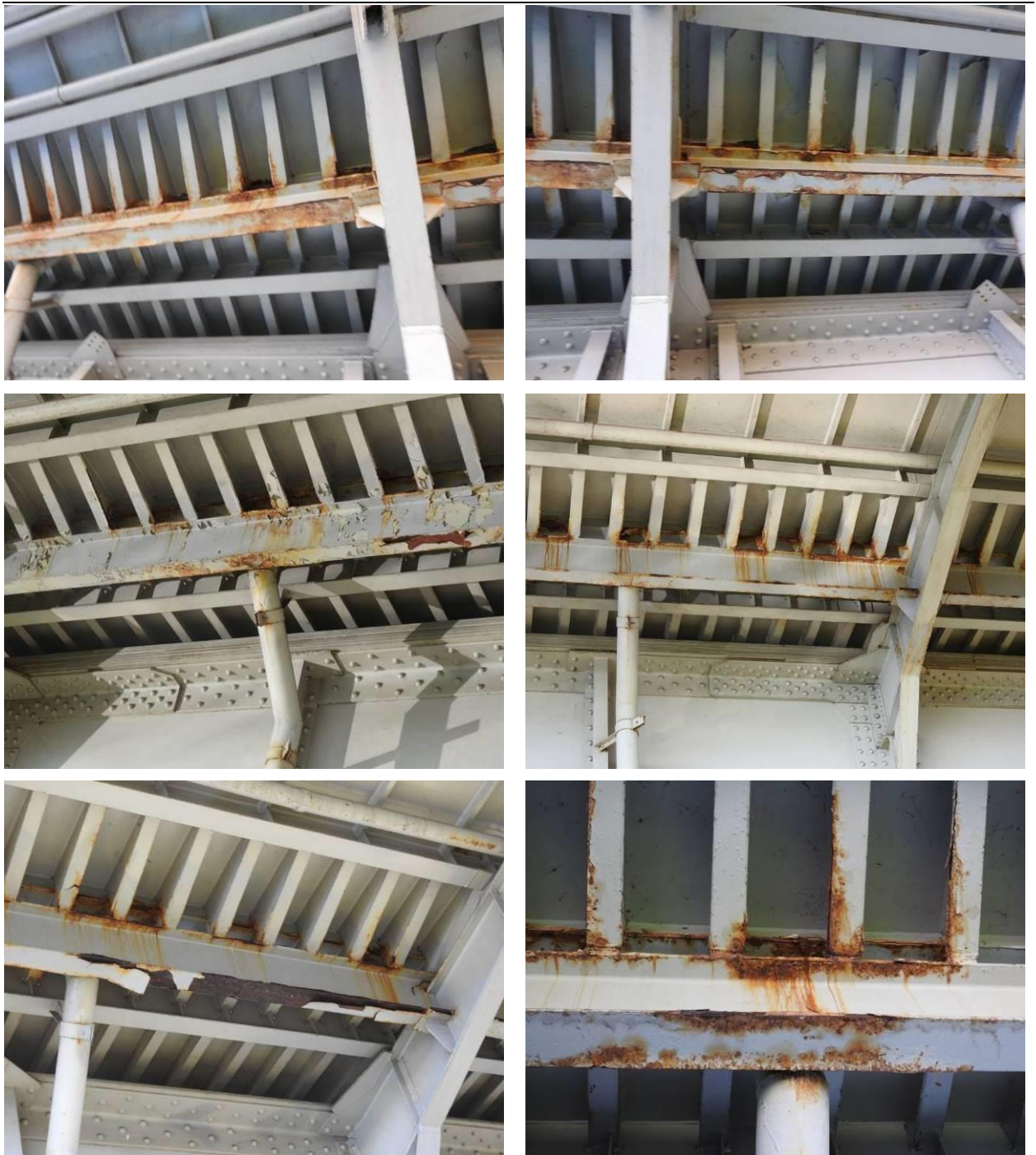
Fot. 3.7. Przykładowe fotografie przedstawiające stan techniczny nawierzchni drogowej na obiekcie – widoczna korozją powierzchniową na belkach podłużnych i żebrach wsporników podchodnikowych.
