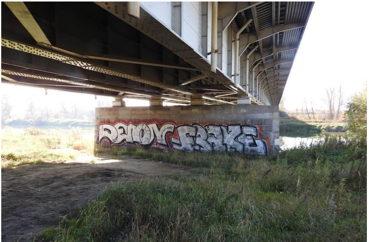
Fot. 1.3. Widok ogólny na filar w terenie zalewowym.
