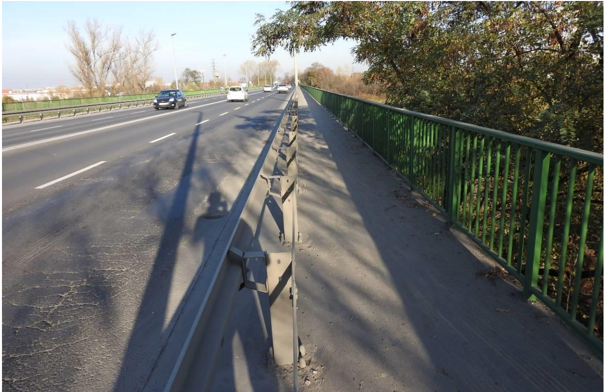
Fot. 1.6. Widok ogólny na obiekt z poziomu jezdni.
