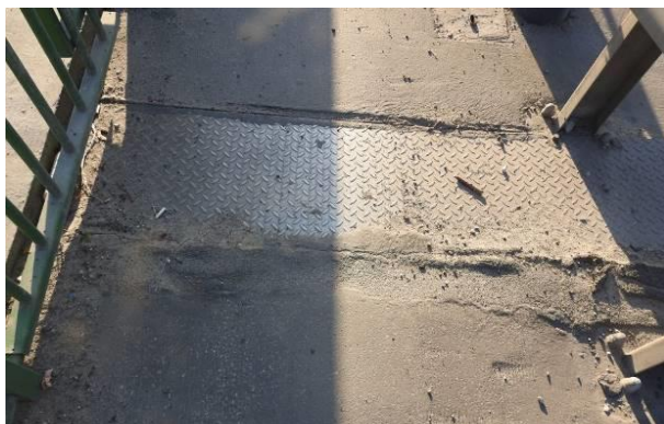
Fot. 3.30. Przykładowe fotografie przedstawiające stan techniczny urządzeń dylatacyjnych na obiekcie.
