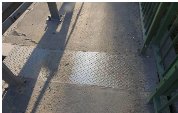
Fot. 3.30. Przykładowe fotografie przedstawiające stan techniczny urządzeń dylatacyjnych na obiekcie.
