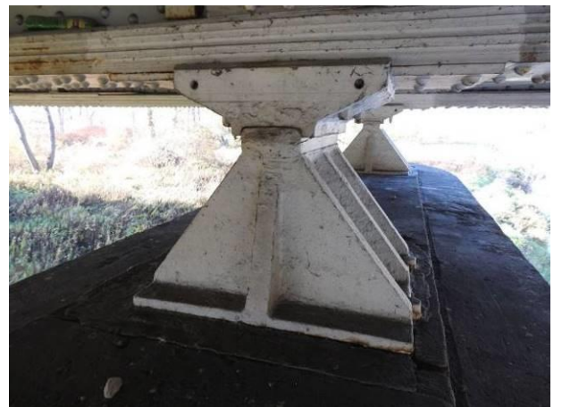
Fot. 3.25. Przykładowe fotografie przedstawiające stan techniczny łożysk stałych znajdujących się na lewobrzeżnym filarze nurtowym – niewielkie ogniska korozji wżerowej w miejscu posadowienia łożyska na filarze.
