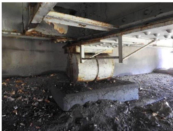
Fot. 3.23. Przykładowe fotografie przedstawiające stan techniczny wałkowych łożysk ruchomych na przyczółku.
