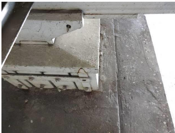
Fot. 3.24. Przykładowe fotografie przedstawiające stan techniczny łożysk ruchomych o ściętych wałkach, znajdujących się na prawobrzeżnym filarze nurtowym – brak widocznych uszkodzeń i zanieczyszczeń.
