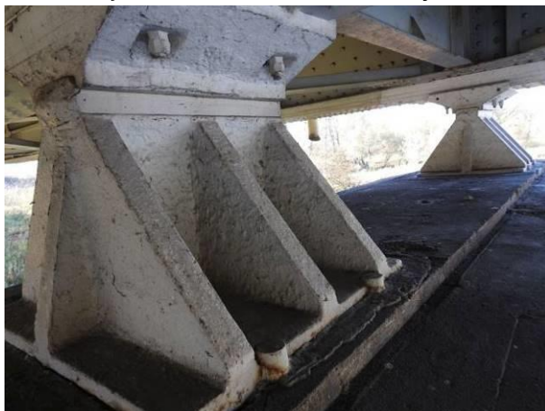
Fot. 3.25. Przykładowe fotografie przedstawiające stan techniczny łożysk stałych znajdujących się na lewobrzeżnym filarze nurtowym – niewielkie ogniska korozji wżerowej w miejscu posadowienia łożyska na filarze.
