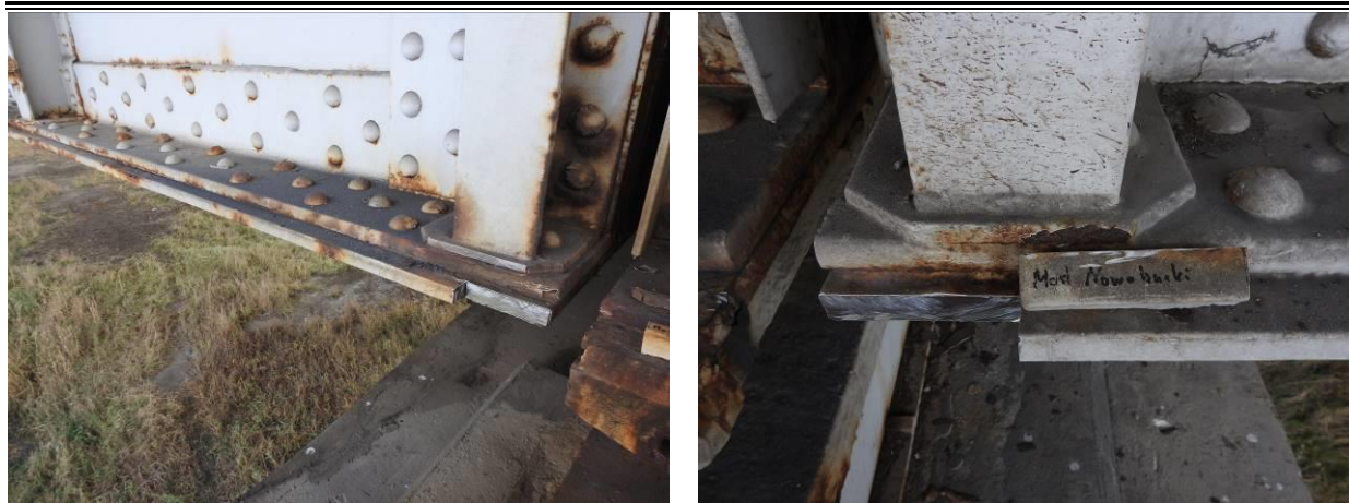
Fot. 4.5. Miejsca poboru próbek stali z konstrukcji blachownicowej.
