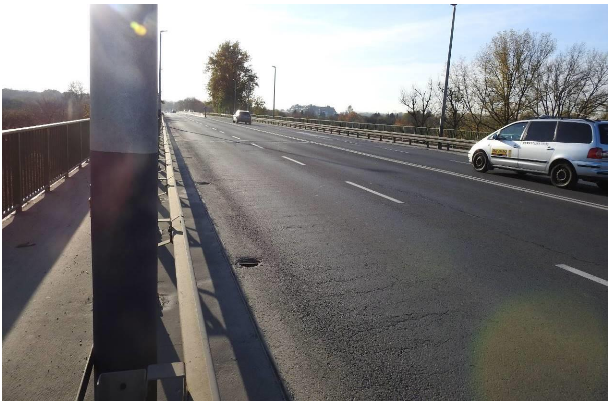
Fot. 1.7. Widok ogólny na obiekt z poziomu jezdni.
