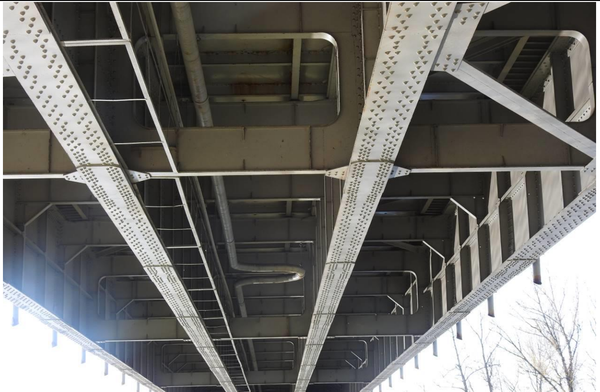
Fot. 1.4. Widok ogólny od spodu na ustrój nośny przęsła.
