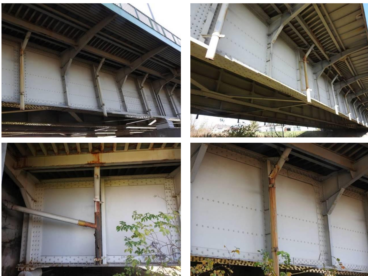
Fot. 3.12. Przykładowe fotografie przedstawiające stan techniczny urządzeń odwodniających na obiekcie.
