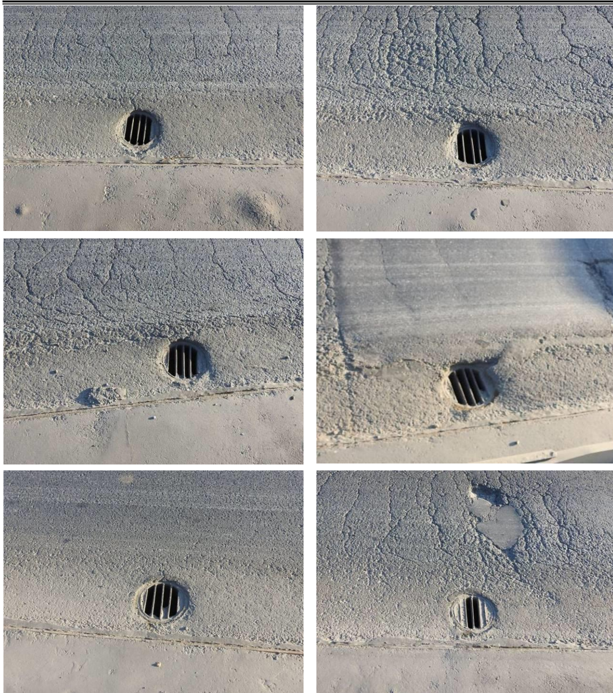
Fot. 3.15. Przykładowe fotografie przedstawiające stan techniczny barier energochłonnej na obiekcie – widoczne spękania i deformacje nawierzchni jezdni w obrębie wpustów
