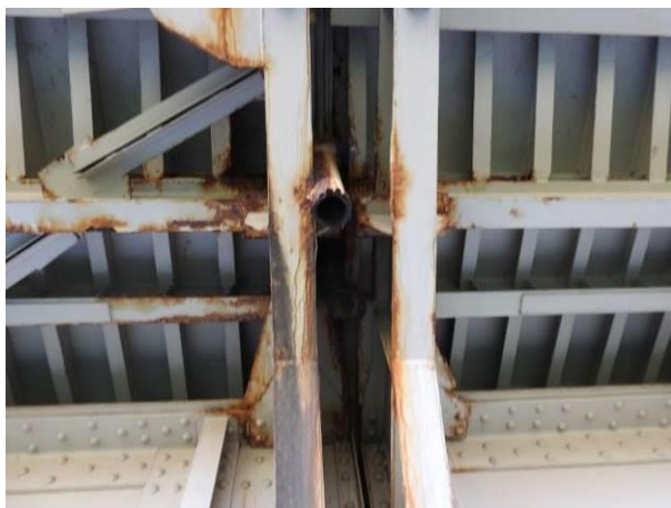
Fot. 3.32. Przykładowe fotografie przedstawiające stan techniczny urządzeń dylatacyjnych na obiekcie.
