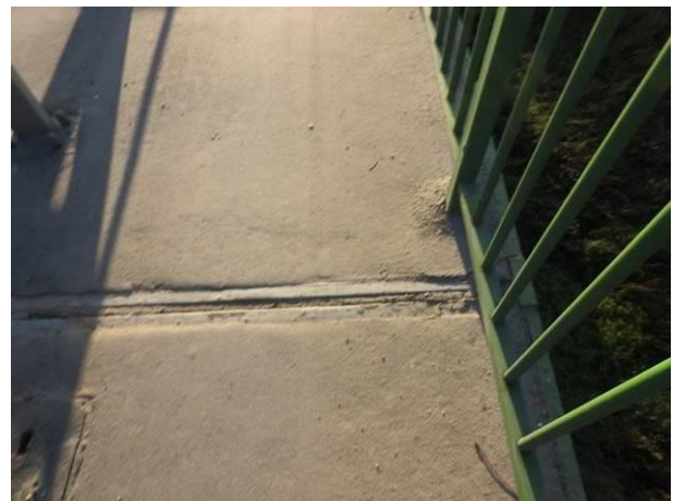
Fot. 3.31. Przykładowe fotografie przedstawiające stan techniczny urządzeń dylatacyjnych na obiekcie.
