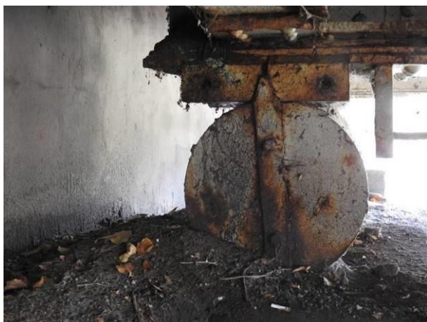
Fot. 3.23. Przykładowe fotografie przedstawiające stan techniczny wałkowych łożysk ruchomych na przyczółku.
