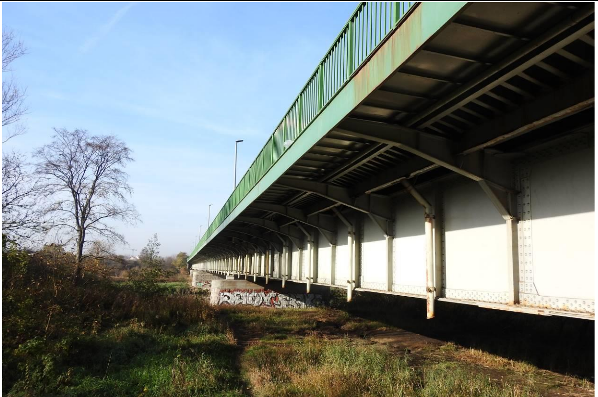
Fot. 1.2. Widok ogólny na przęsło obiektu.
