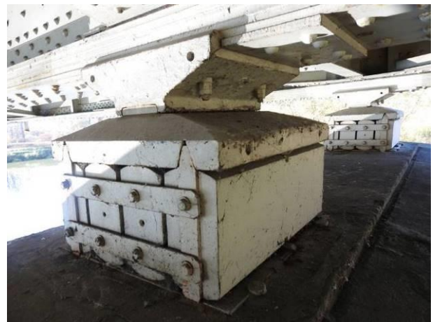
Fot. 3.24. Przykładowe fotografie przedstawiające stan techniczny łożysk ruchomych o ściętych wałkach, znajdujących się na prawobrzeżnym filarze nurtowym – brak widocznych uszkodzeń i zanieczyszczeń.
